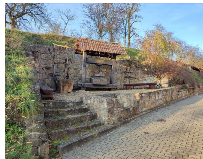
| Různé přístupy k práci se svahem a jeho využitím - zvýšený pobytový prostor s opěrnou zdí
